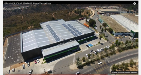
Photovoltaikanlage von Grammer Solar in Viña del Mar, Chile. © Grammer Solar
