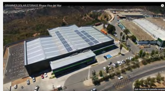
Sistema fotovoltaico de Grammer Solar en Viña del Mar © Grammer Solar
